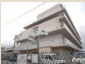
介護療養型老人保健施設 ベルセウス外観（工事中）
